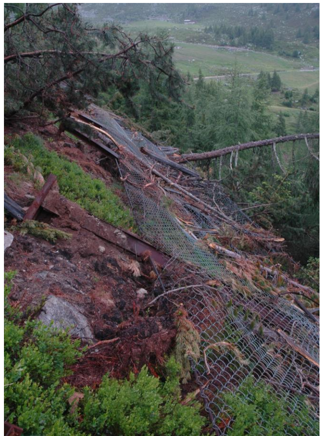
Abbildung 34: Zerstörter Triebsschneezaun mit Rauchkofelspitze (links). Vom Luftdruck umgelegter Schneezaun (rechts)
