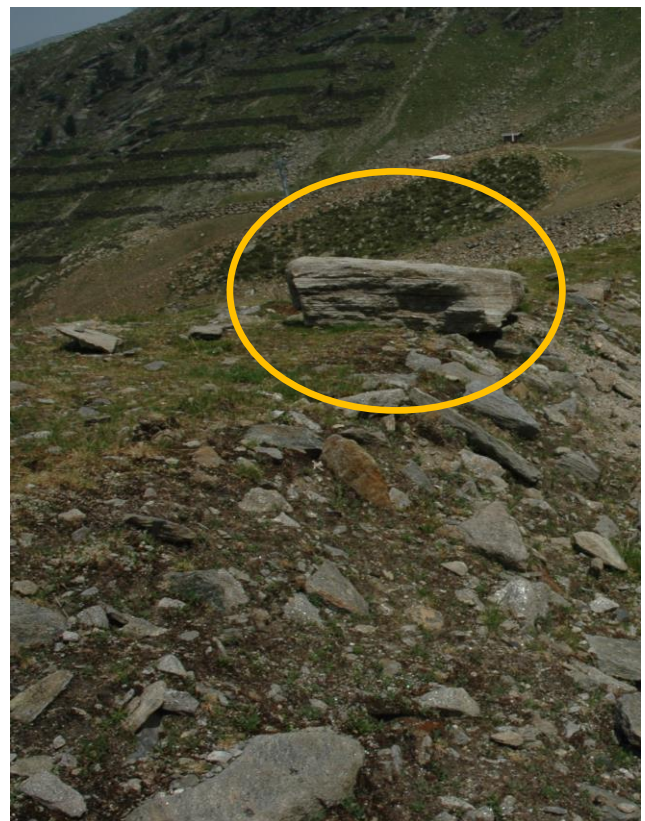
Abbildung 41: Die Obere Böden Lawine im Skigebiet Pfelders überfährt beide Lawinenauffangdämme (links). Ein über 1500kg schwerer Zyklopenstein wurde beim obersten Lawinenauffangdamm von der Zyklopenmauer auf die Dammkrone befördert (rechts)
