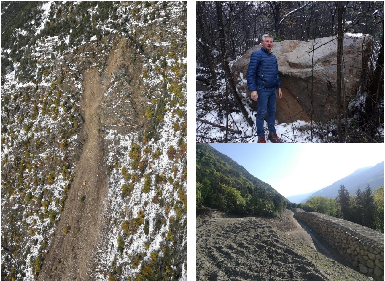
Abbildung 20: Links die Abbruchnische und die Sturzbahn des Felssturzereignisses. Rechts einer der Sturzblöcke sowie der fertiggestellte Steinschlagschutzdamm bergseitig der Vinschgauer Staatsstraße
